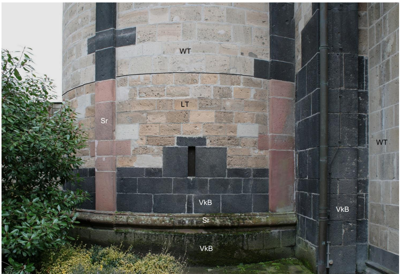
Abb. 11 Westwerk, Nördlicher Flankenturm, Quadermauerwerk vor 1100 mit Veitskopf-Basanit (VkB), Laacher Tuff (LT), Buntsandstein (Sr) sowie Weiberner Tuff (WT) aus der M. des 12. Jh.
