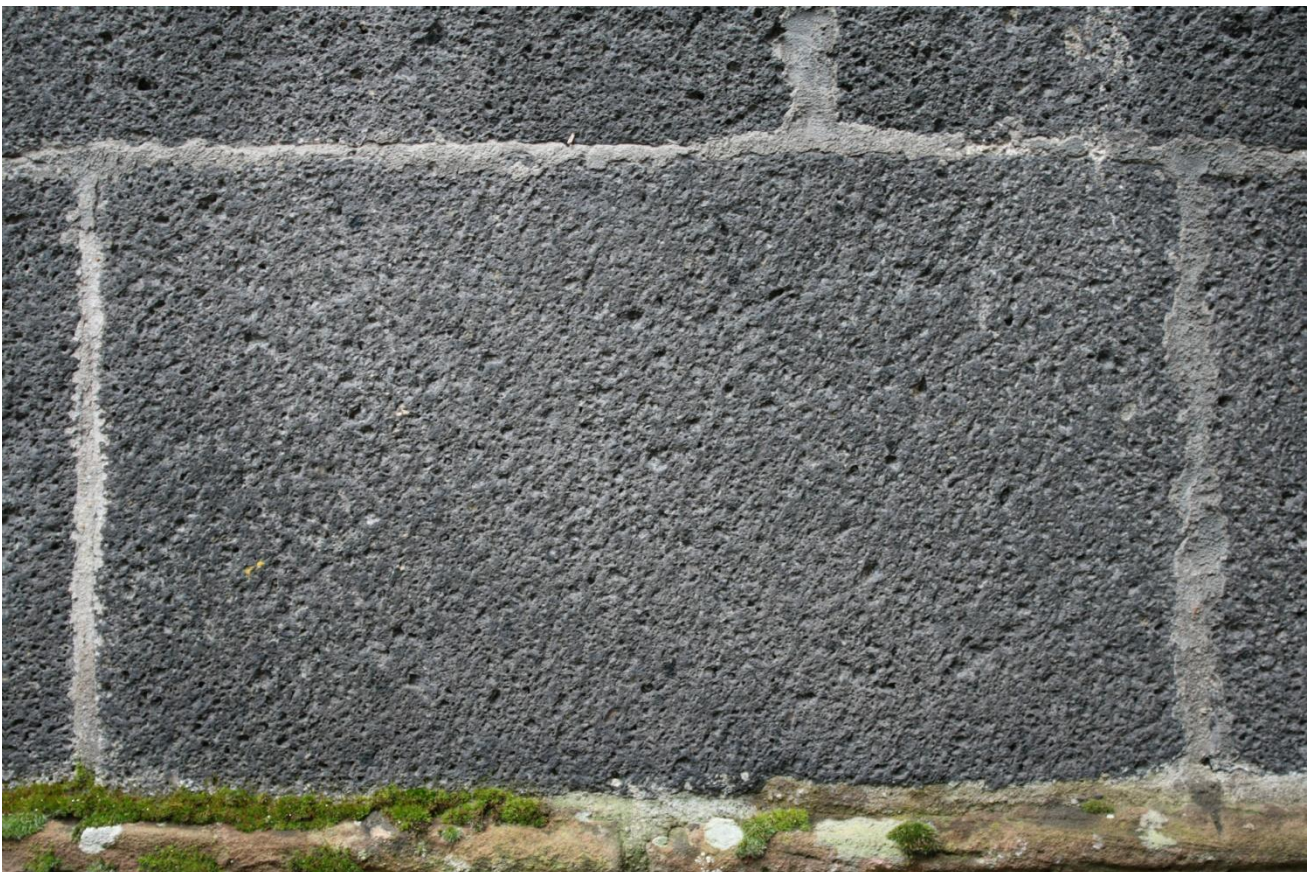
Abb. 13 Westwerk, Nördlicher Flankenturm, Quadermauerwerk aus Veitskopf-Basanit
