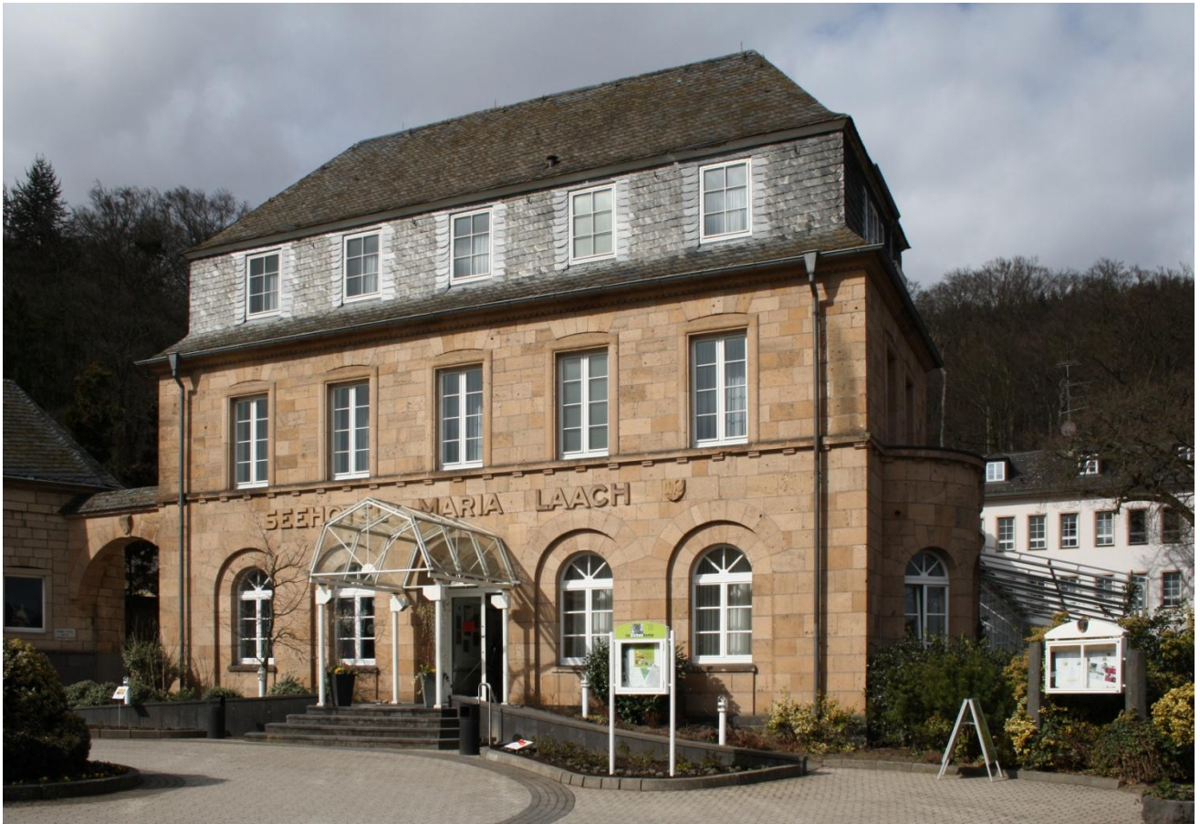
Abb. 22 Seehotel Maria Laach, Eingangstrakt in Laacher Tuff von 1920
