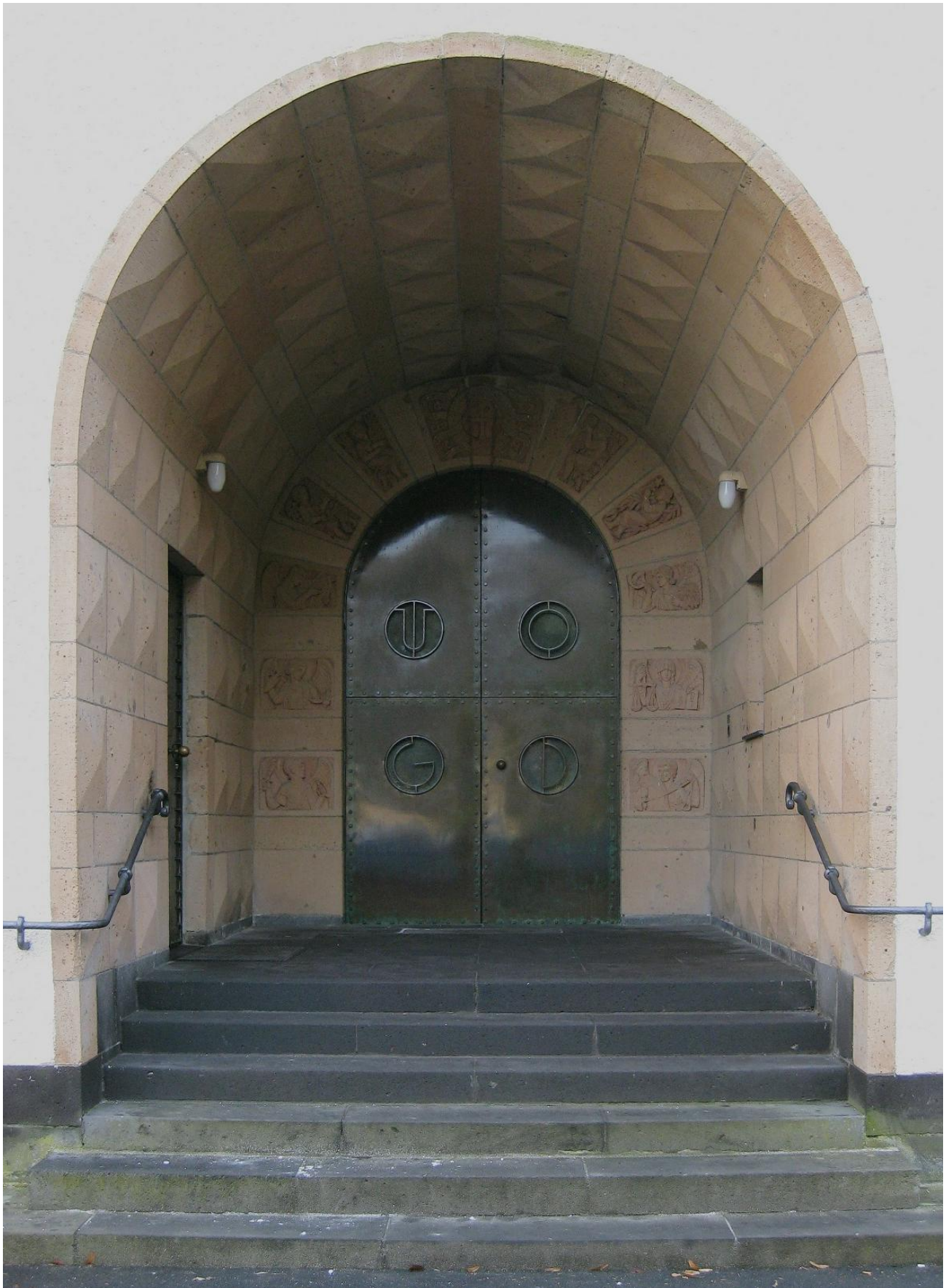
Abb. 27 Gastflügel St. Gilbert , Eingangsbereich des Pfortenbaus, Verblendung in Laacher Tuff, 1928-1929
