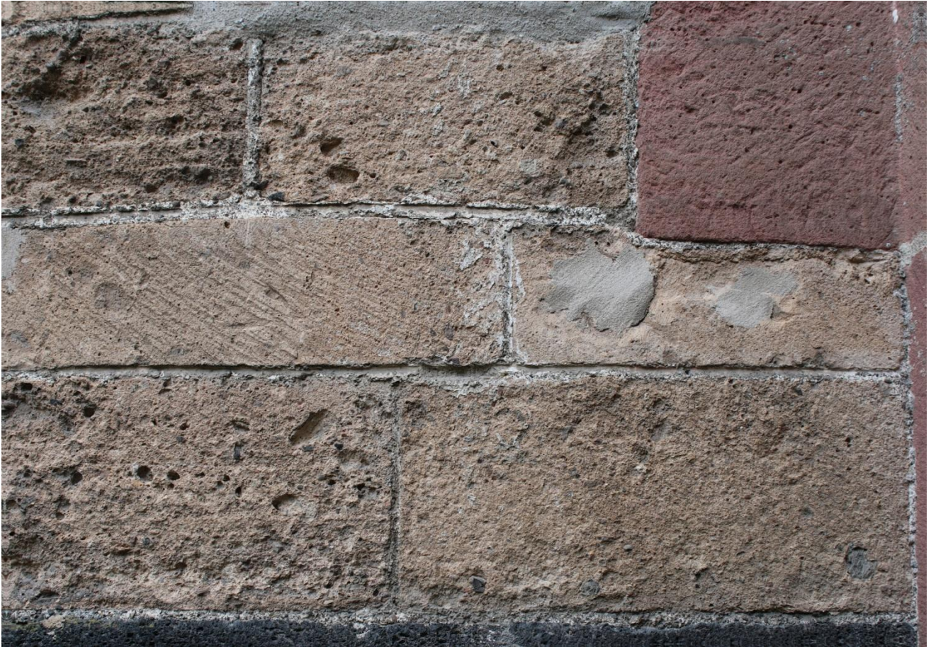
Abb. 12 Westwerk, Nördlicher Flankenturm, Quadermauerwerk aus Laacher Tuff, Binder der Lisene aus Buntsandstein (rechts oben) und Sockel aus Veitskopf-Basanit (angeschnitten unten)
