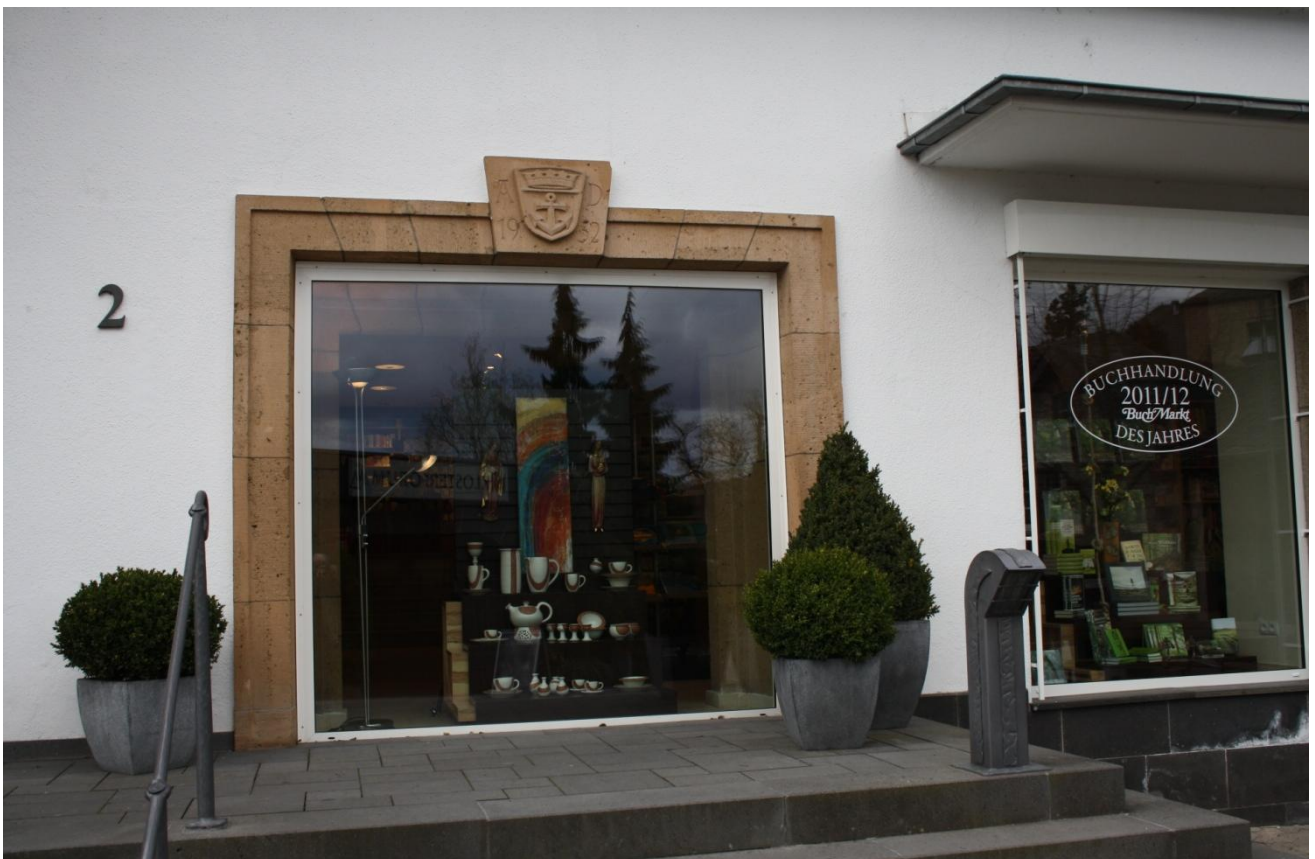
Abb. 25 Maria Laach, Buchladen 1913, Portal in Laacher Tuff von 1952
