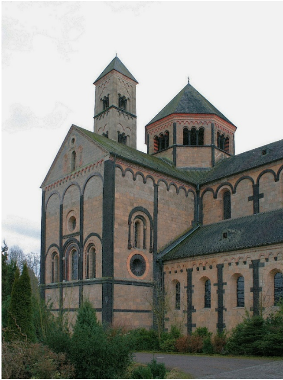
Basilika, Nordquerhaus und Vierungsturm
